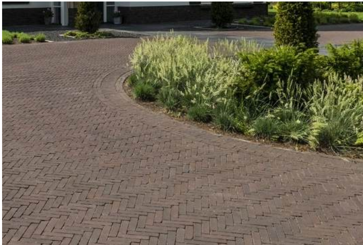
waalformaat kleiklinker visgraat verband met rollaag en strek
