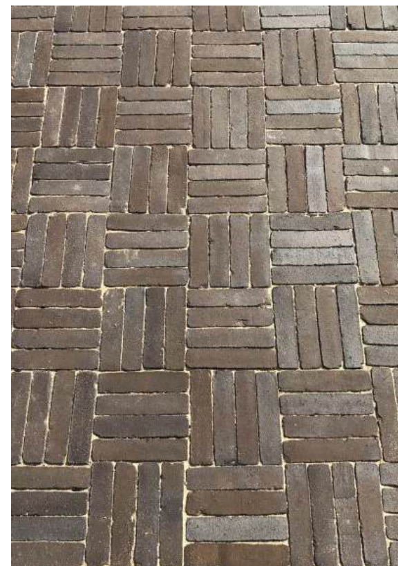
waalformaat kleiklinker blokverband
